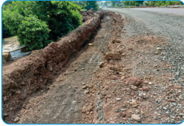
झोपडपट्टी ते रेल्वे स्टेशनपर्यंत नवीन ६ इंची पाईप लाईन टाकणे (इस्टिमेटनुसार 12लाख रु.)
