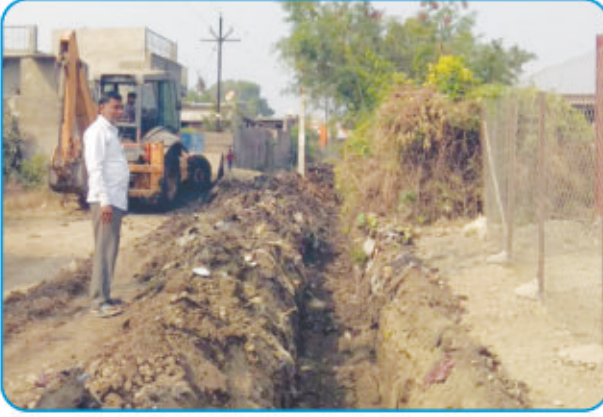
मधुकर गाढे यांचे घराजवळ जेसीबी ने नाली खोदकाम
