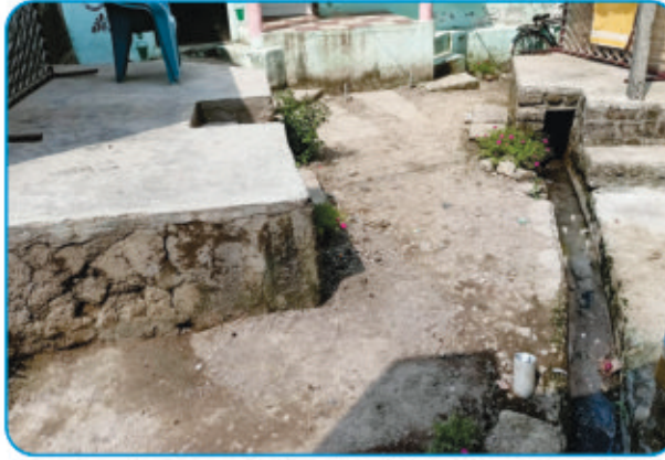
क्षारामुळे खराब झालेली पाईप लाईन बदलून नवीन टाकणे
