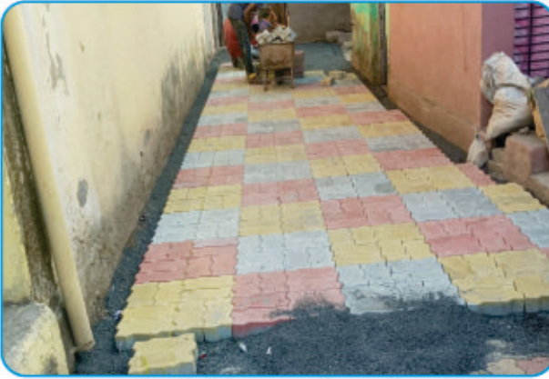
भास्कर मंडवाले यांचे घराजवळ पेव्हर ब्लॉक बसविणे
