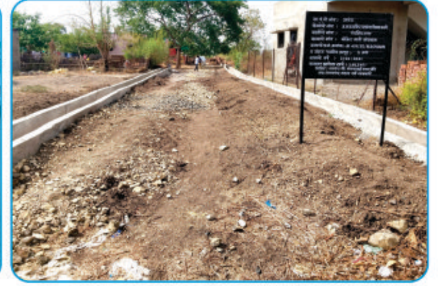
पंचशिल नगरमध्ये सिमेंट नाली बांधकाम
